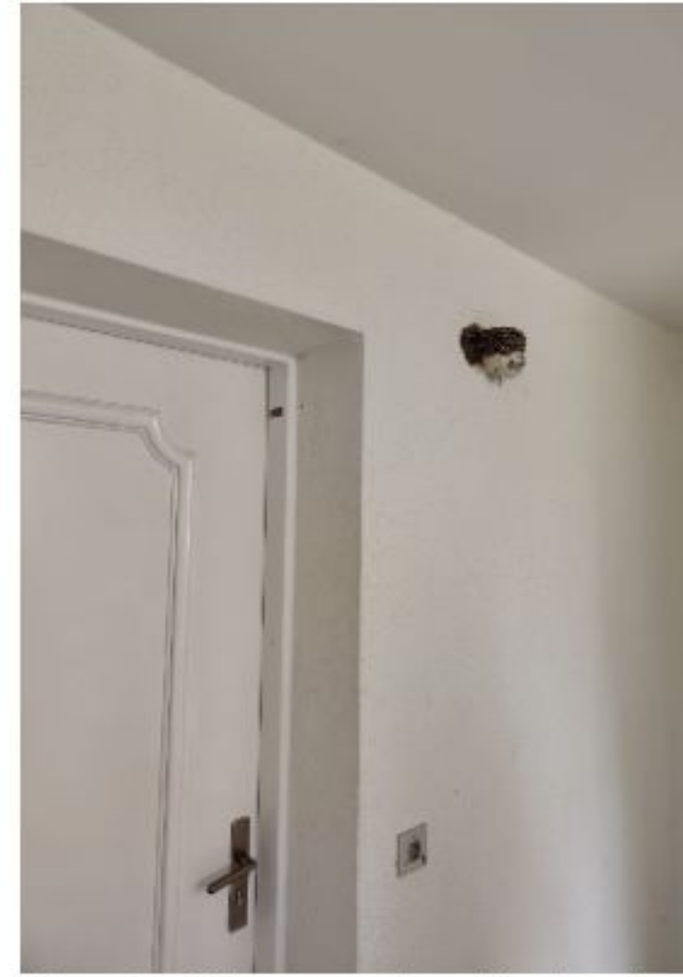
Figure 9 : Nid recouvrant un détecteur de mouvement proche d'une porte d'entrée
